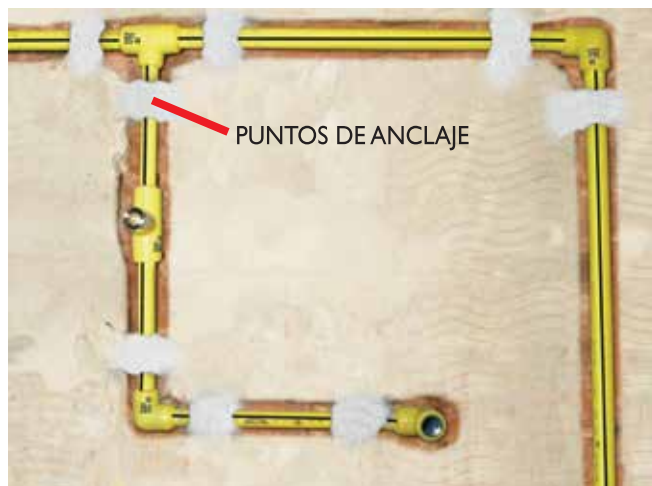
Vista parcial de instalación.
