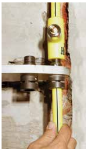
Thermofusión en la canaleta.
