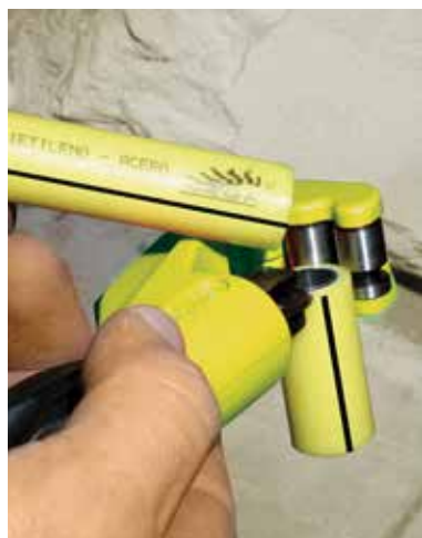
Corte con corta-tubo en obra.
